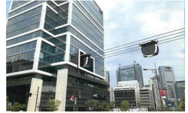
写真：Zip Infrastructure(株)
