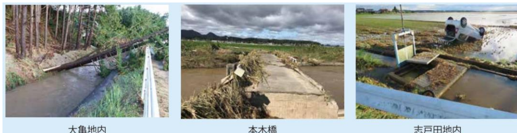
図 3-5-13 本市における令和元年の台風19号による被害状況
