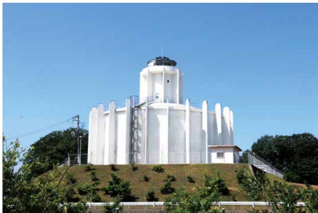
富谷市と仙台市の境にそびえる給水施設・シンフォニータワー（富谷配水池）
