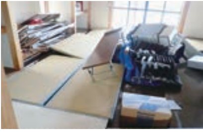
▲ 床上浸水（三ノ関会館）
