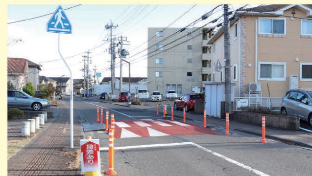
可搬型スムーズ横断歩道が設置された成田四丁目第2公園付近
