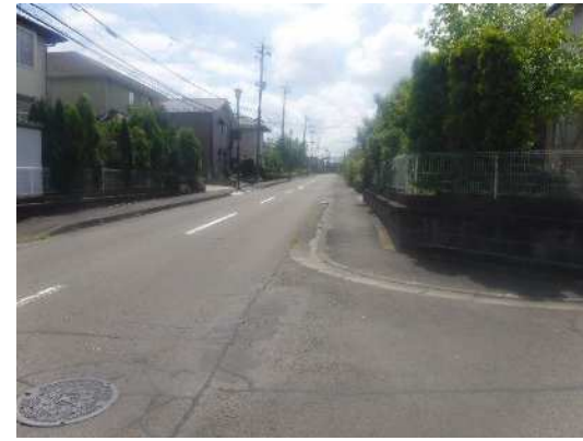
写真⑦ 盛土境界付近
