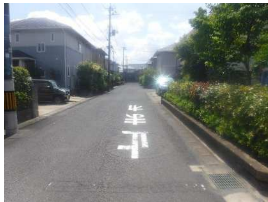
写真⑭ 盛土境界付近
