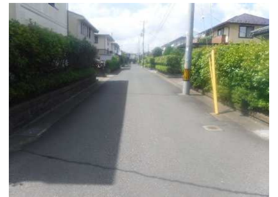
写真⑯ 盛土境界付近
