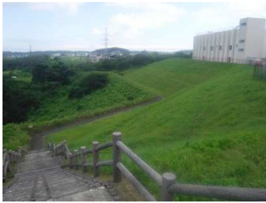
写真① 盛土末端全景
