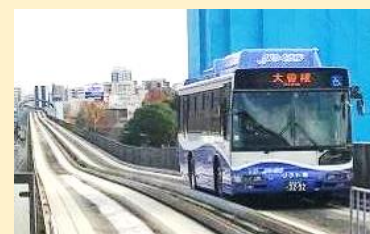
○ガイドウェイ・ランジット整備
