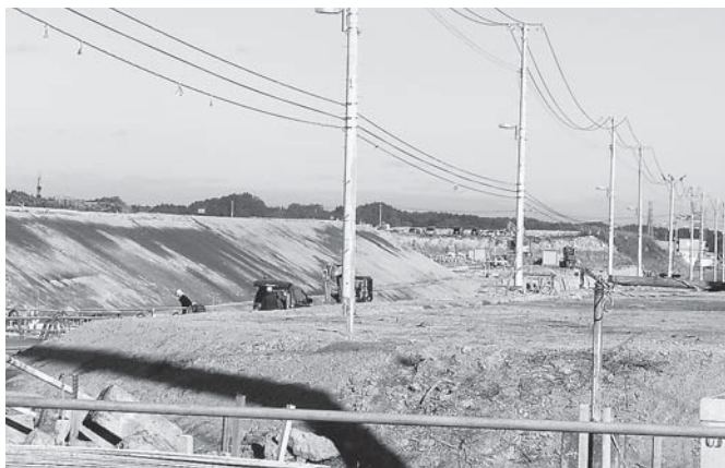
▲ 明石台東地区造成工事
