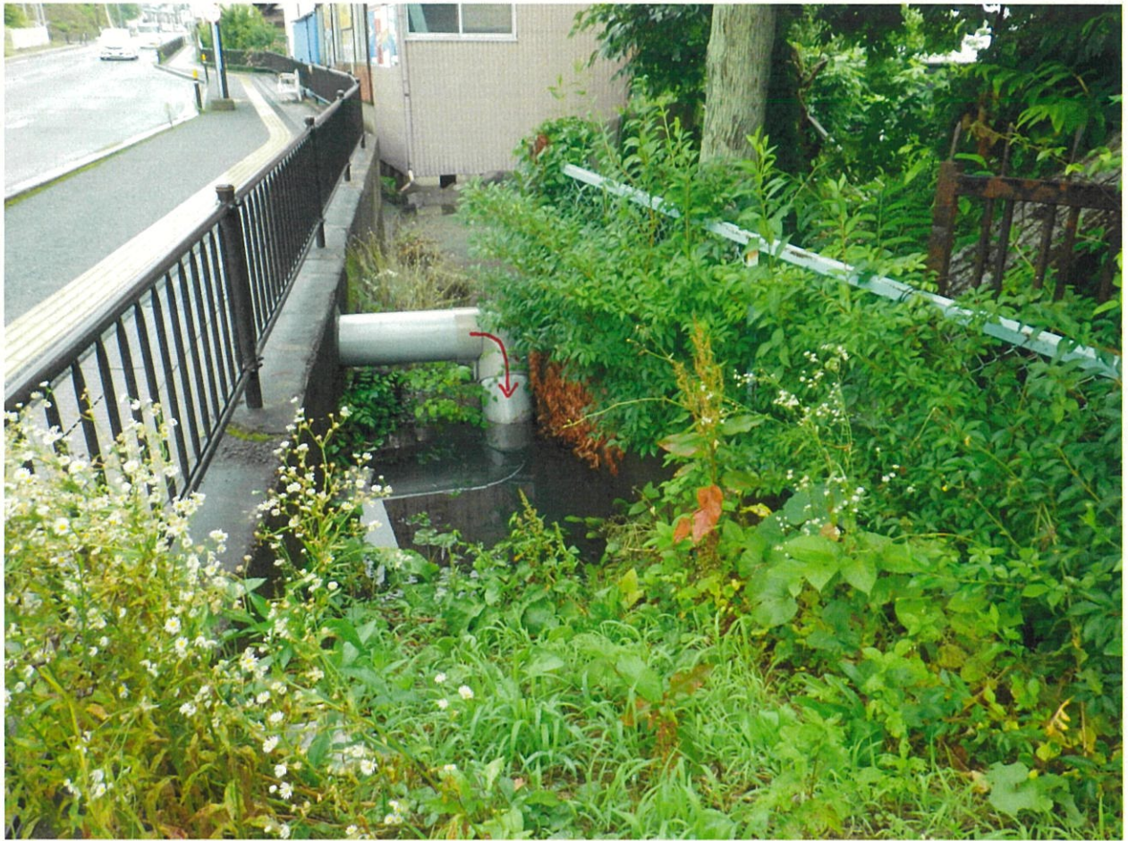
現場確認／R040713 仏所太子堂中線の雨水排水
