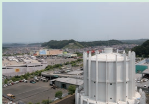
富谷配水池からの眺め。白い建物は富谷第二配水池
