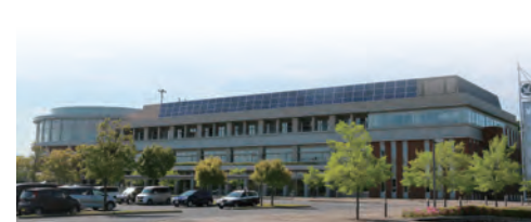
富谷市役所本庁舎
