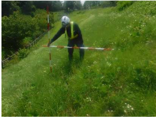
写真③③ 盛土のり面勾配
