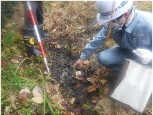
写真③⑤ 盛土のり尻湧水再確認状況（湧水有）
