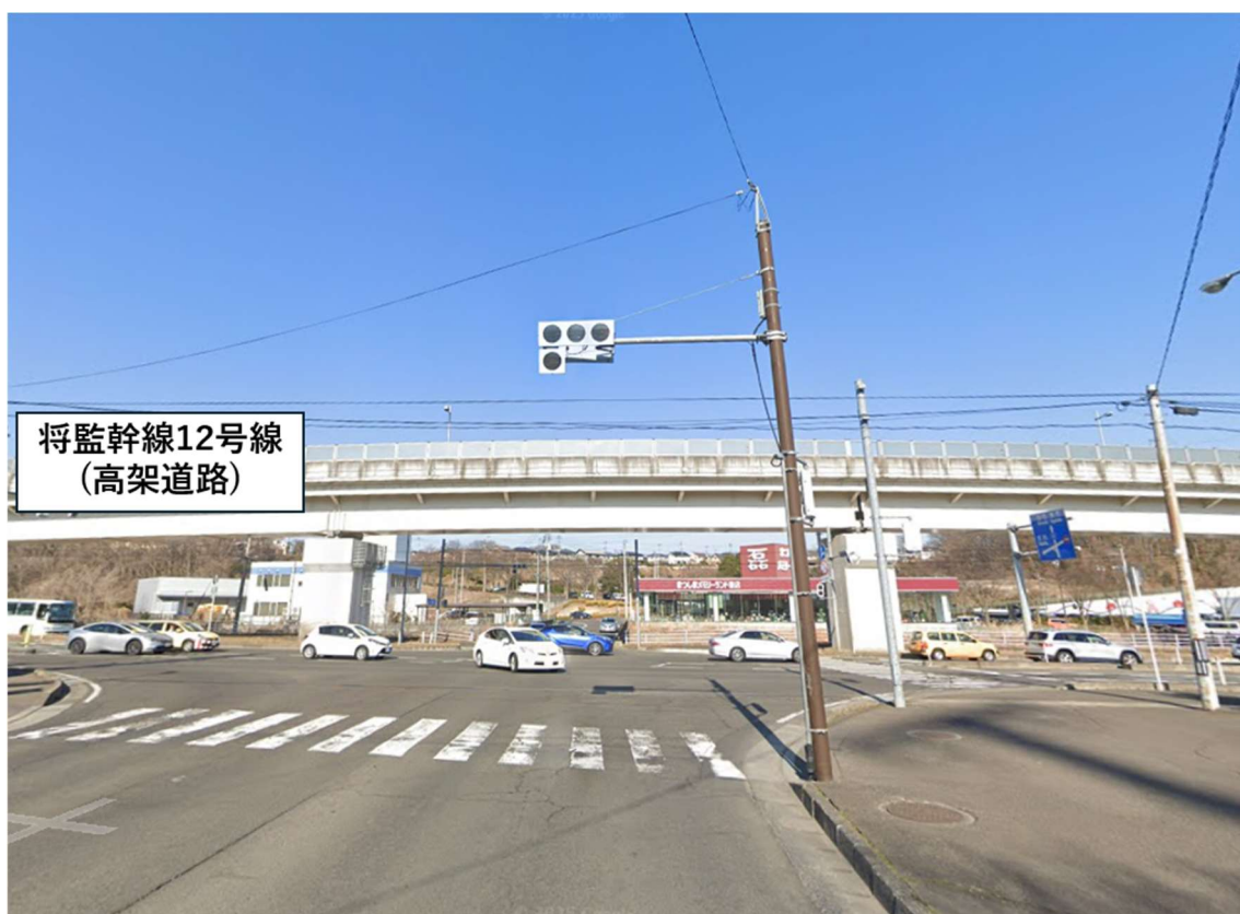
図 4-8 将監幹線 12 号線(高架道路)の横断周辺の現況写真(ルート②)
