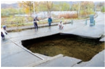
▲ 道路陥没（北海道三笠市）
