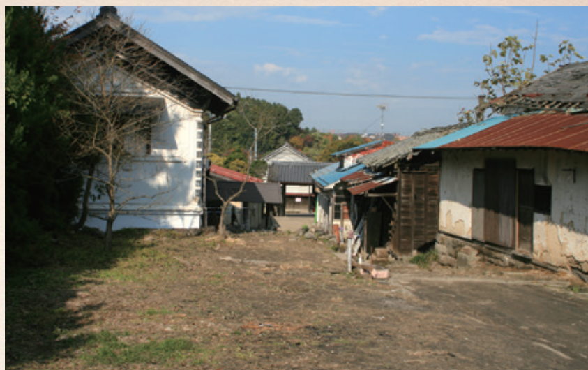
みそしょうゆを製造していた頃の建物が残る旧内ヶ崎醤油店
