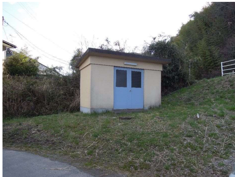
明石配水ポンプ場
