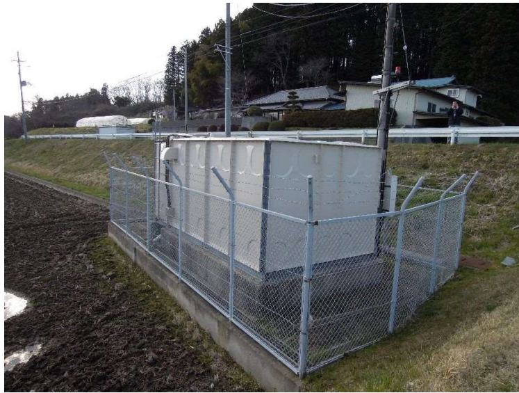
石積NO.2配水ポンプ場
