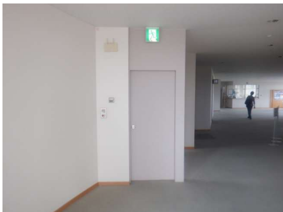
○天井直付型 片面型 B 級通路誘導灯
