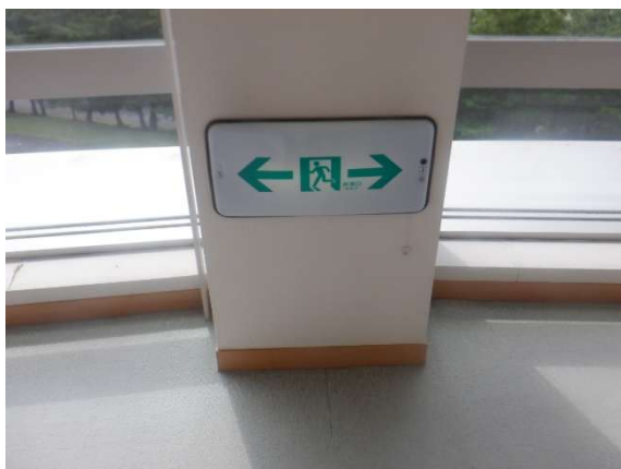
○壁埋込型 片面型 C 級通路誘導灯
