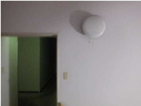
○壁直付階段非常照明灯 丸形
