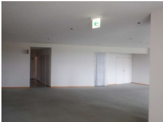
○天井吊下型 両面型 B 級避難口誘導灯
