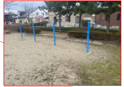
鉄棒撤去 N = 1 基
