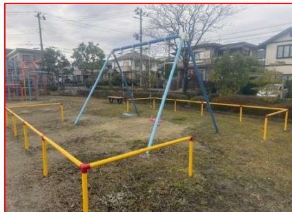
大型プランコ撤去 N = 1 基
