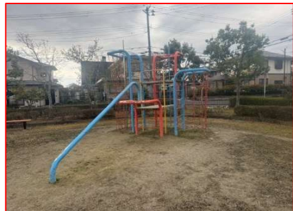
鉄製ジャングル撤去 N = 1 基
