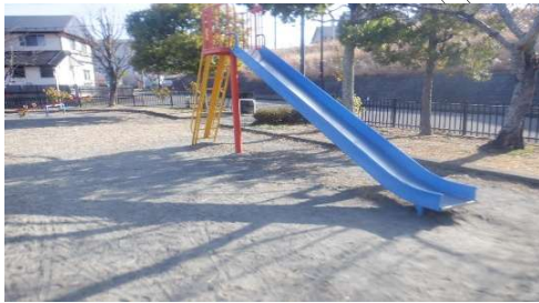
大型滑り台撤去 N = 1 基
