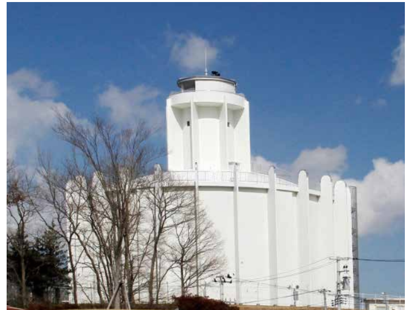
シンフォニータワー（富谷配水池）
