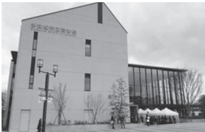
▲ 多賀城市立図書館
