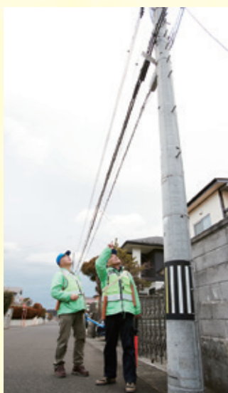
防犯灯の球切れなども夜間のパトロールでチェック
