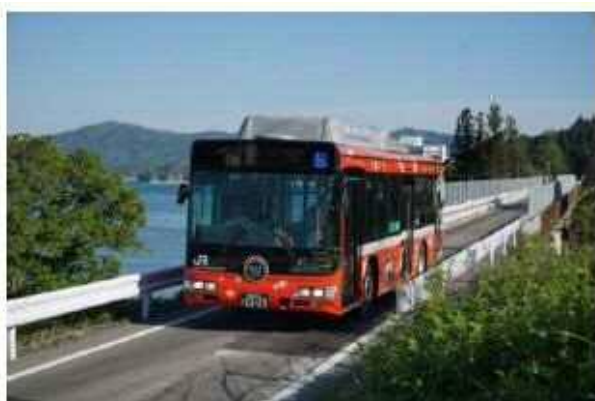
図 1-20 バス専用道を走行する気仙沼線・大船渡線 BRT の標準的な区間の横断構成 (1車線)
