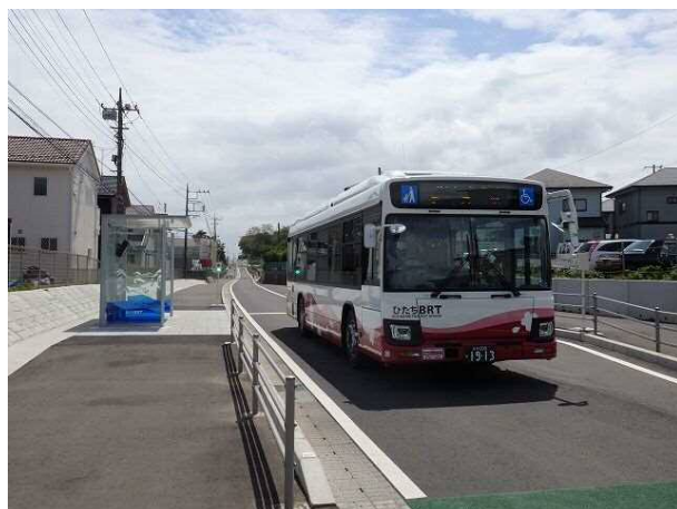
大沼(BRT) 停留所
