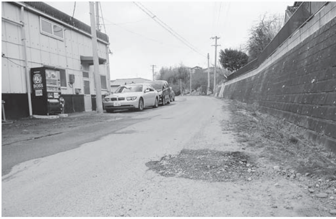
▲ 町道源内明坂線
