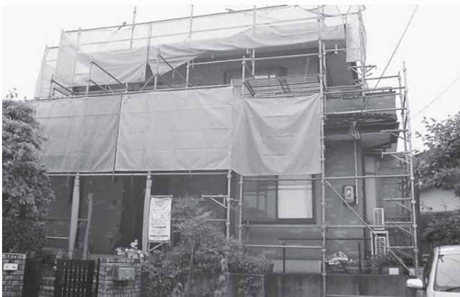
▲ 被災した住宅
