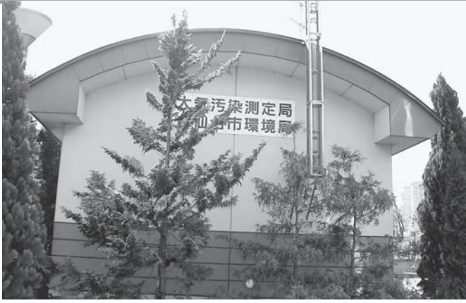
▲ 大気汚染測定局 (仙台市泉区)
