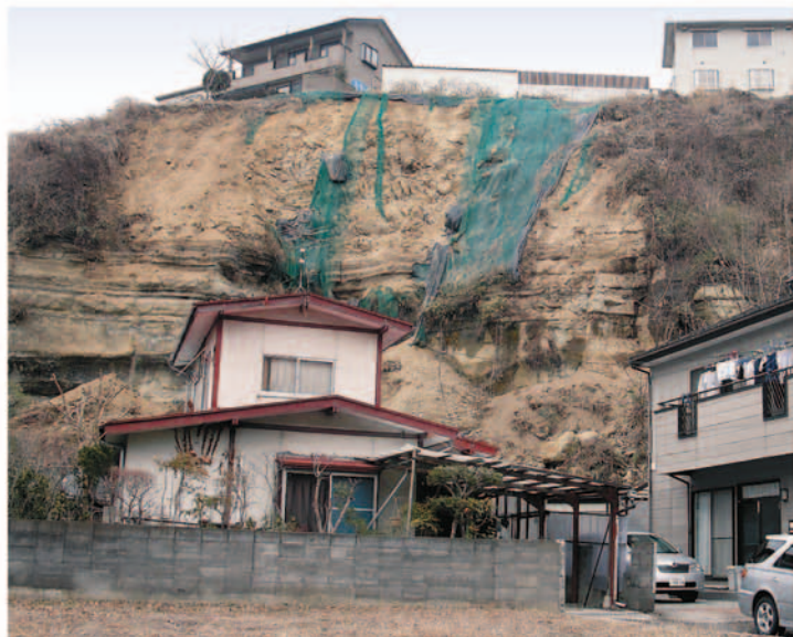
東向陽台一丁目の急傾斜地の崩落
