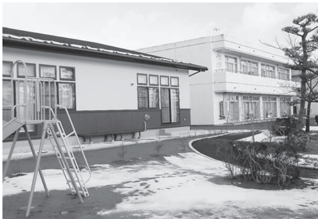
▲ 新(左)・旧(右・2階)富ヶ丘北部会館
