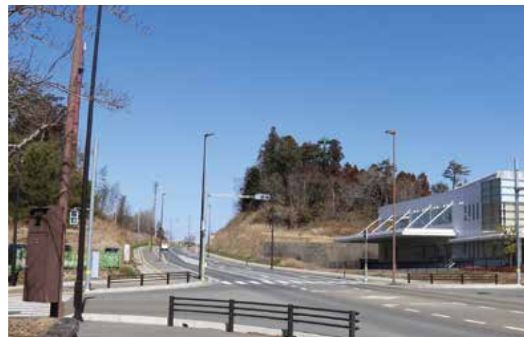
穀田三ノ関線（令和7年3月開通）
