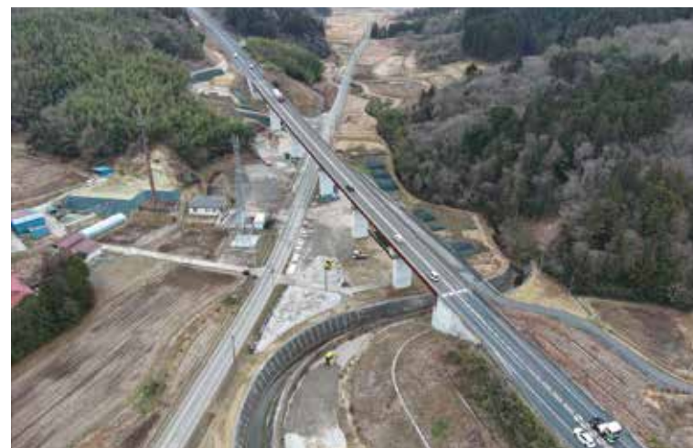
4車線化の整備を進める仙台北部道路
