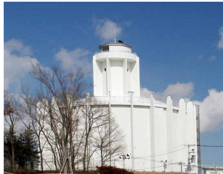
シンフォニータワー（富谷配水池）
