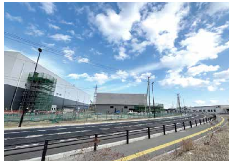
高屋敷西工業団地
