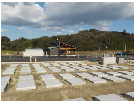
芝生墓地及び管理棟（工事中的の様子）
