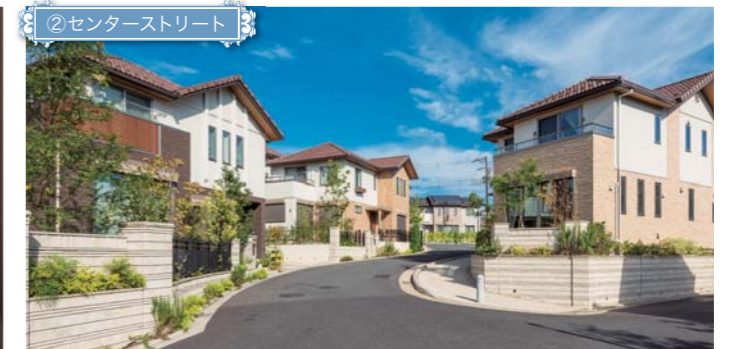
ゆとりある歩道が設けられた、地域との接点にもなる「センターストリート」。
